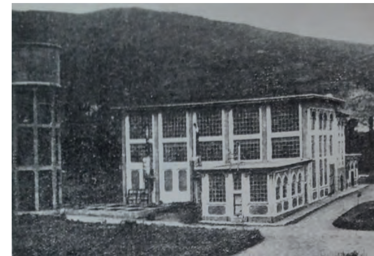
Resim 3. Bursa Elektrik Santrali'nin 1934'teki görünümü, doğu cephesinde özgün pencere açıklıkları ve demir doğramaları (Ceyhan, 1999).
