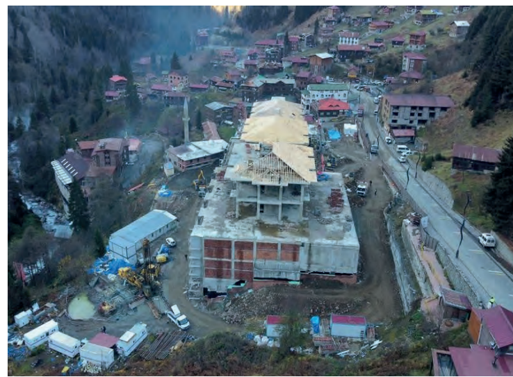
Resim 13. Yeni Ayder kaplıca binası yapım aşaması (URL-6).
