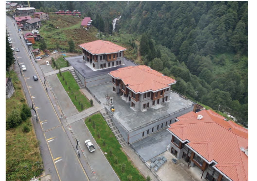
Resim 15. Kaplıca, konaklama ve ticaret yapısı bitmiş hali (yoldan görünüm) (URL-7).
