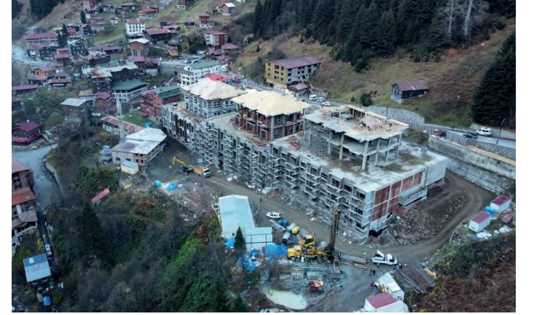
Resim 14. Yeni Ayder kaplıca binası yapım aşaması (URL-6).
