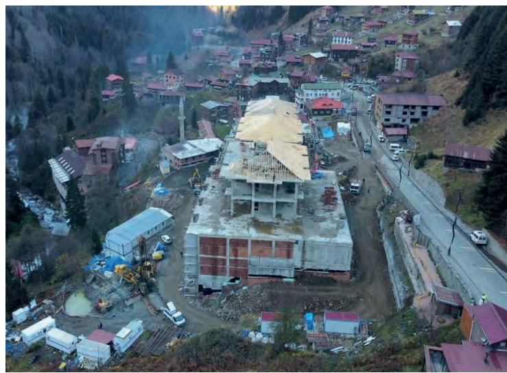
Resim 13. Yeni Ayder kaplıca binası yapım aşaması (URL-6).
