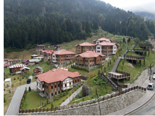
Resim 8, 9. Ayder'de TOKİ eliyle inşa edilen apart oteller (URL-3).
