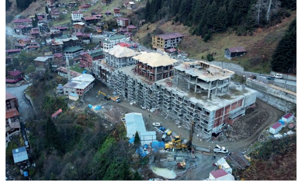
Resim 14. Yeni Ayder kaplıca binası yapım aşaması (URL-6).
