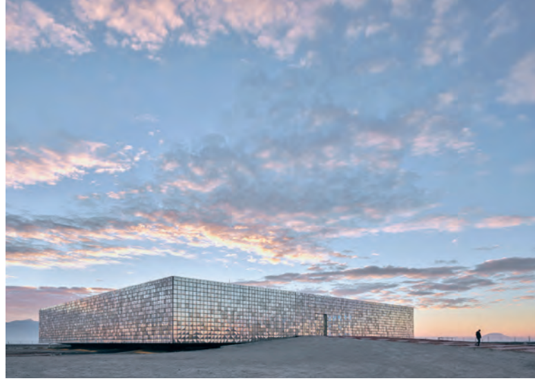
Karapınar Ges Merkezi Kontrol Binası.
