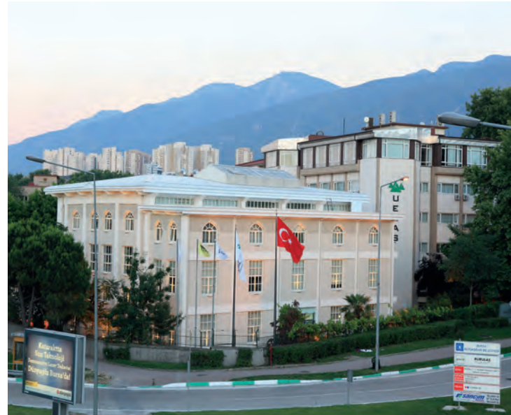
Resim 7. Bursa Elektrik Santrali'nin 2012 restorasyonundan sonraki güncel hali (Kaynak: CLK Holding Arşivi, 2014).
