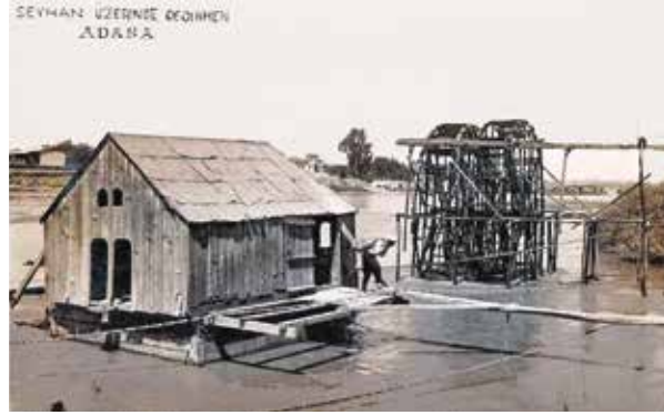
Dünyanın en eski hidrodinamik yapılarından Adana Su Değirmenleri ve şehire su taşıyan Mavra'lar. (suyu taşıyan çarklar)
